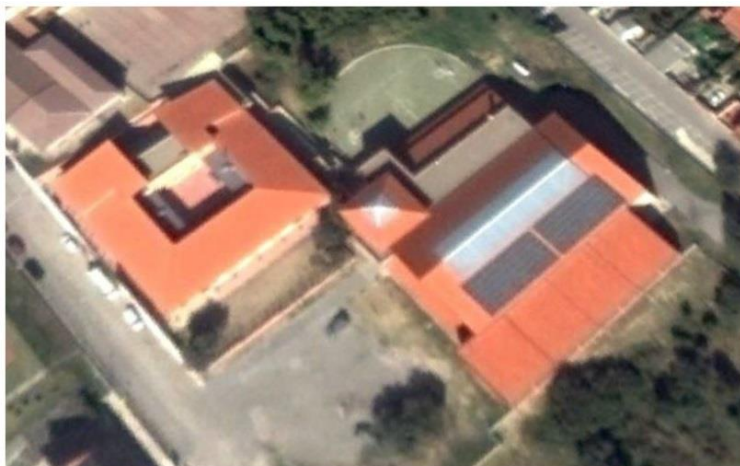
Figura 3. Instalaciones fotovoltaicas del Polideportivo Municipal (Google Earth).
