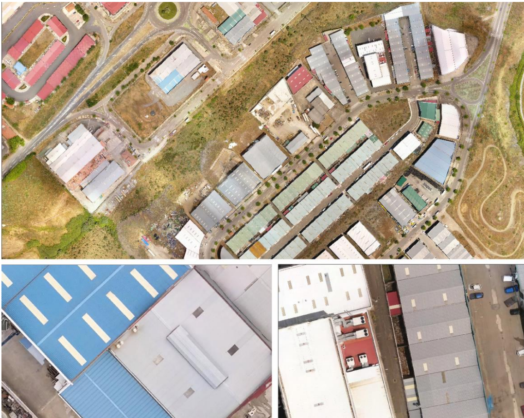
Figura 5. Ortofotos del vuelo fotogramétrico. Polígono industrial de Plasencia.
