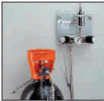
*Figura 6. Central manual de gases.*
