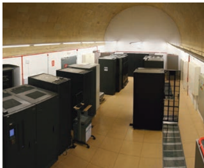
Instalaciones de CETA-CIEMAT. CETA-CIEMAT Facilities.
