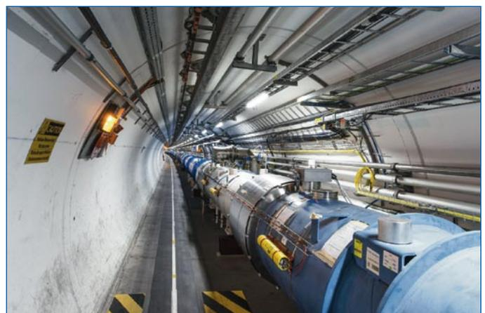
Figura 2: Imagen del túnel del acelerador LHC. El tubo en la parte inferior derecha de la imagen contiene los imanes superconductores que dirigen el haz de partículas.
