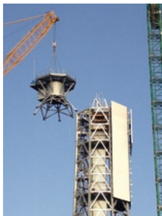
Colocación de la plataforma en el CTAER.
