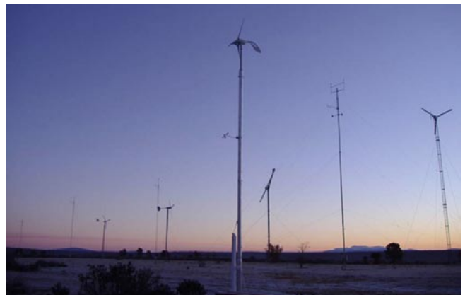
Instalaciones de eólica en el CEDER-Soria.
