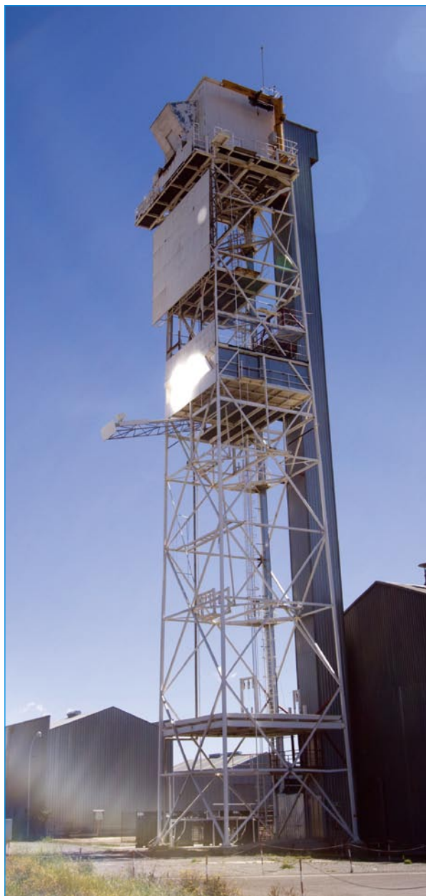
Torre del proyecto HYDROSOL, en la Plataforma Solar de Almería. Tower of HYDROSOL Project at the Plataforma Solar de Almería.
