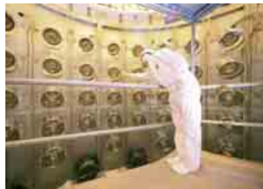
Fin de la instalación de los tubos fotomultiplicadores. F. Rhodes. “Por cortesía de CEA-Saclay”.
