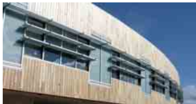
Fachada Sur del edificio de la Fundación ASPRONA- Grupo Lince.
