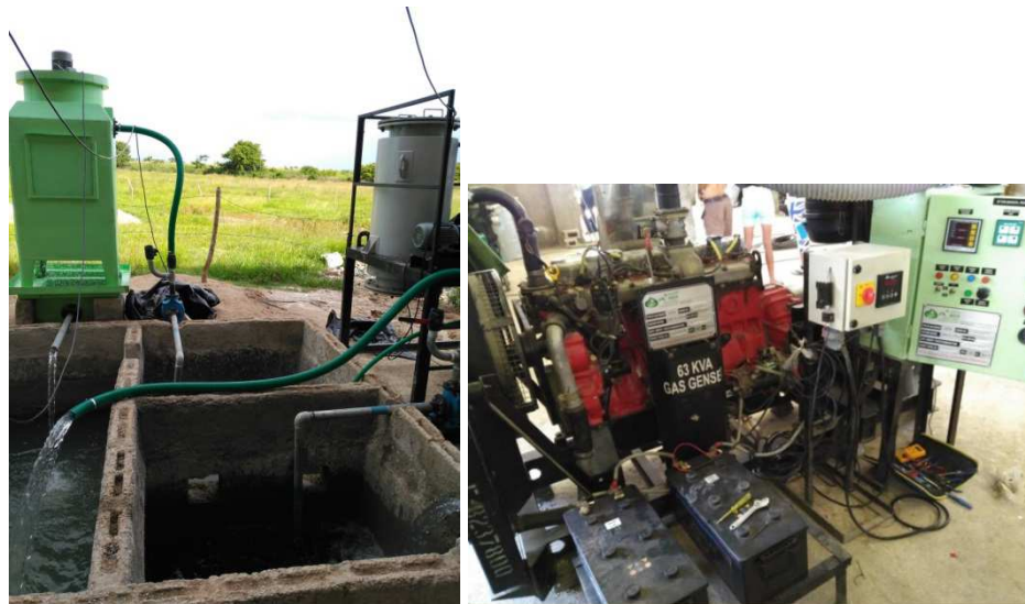
Figura 6.4. Sistema de tratamiento de agua de lavado, piscina y reactores de tratamiento (izquierda) y motor de combustión interna para generación eléctrica (derecha)
