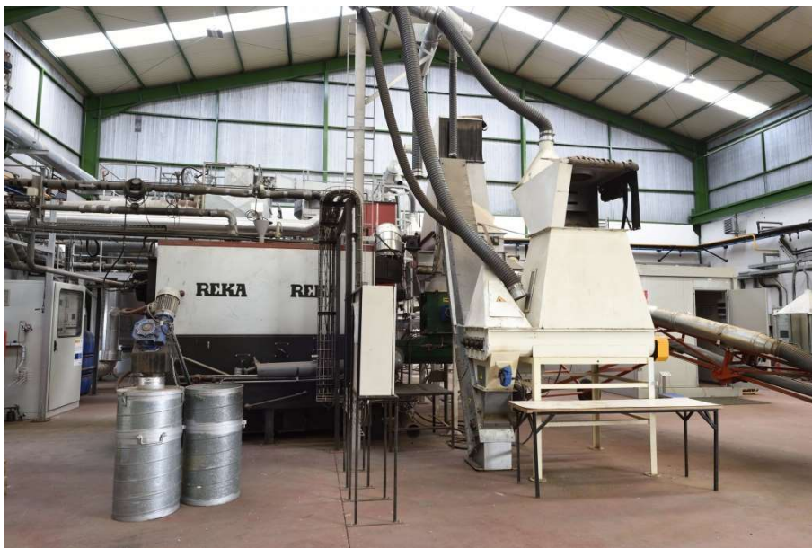
Figura 5: Caldera experimental de combustión en parrilla móvil.
