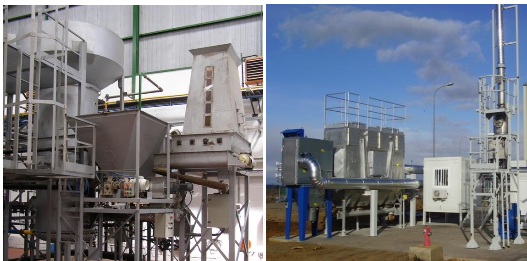
Figura 7. Planta de combustión de lecho fluidizado de 1\text{MW}_t (izquierda) y línea de depuración del gas (derecha), en CEDER-CIEMAT.
