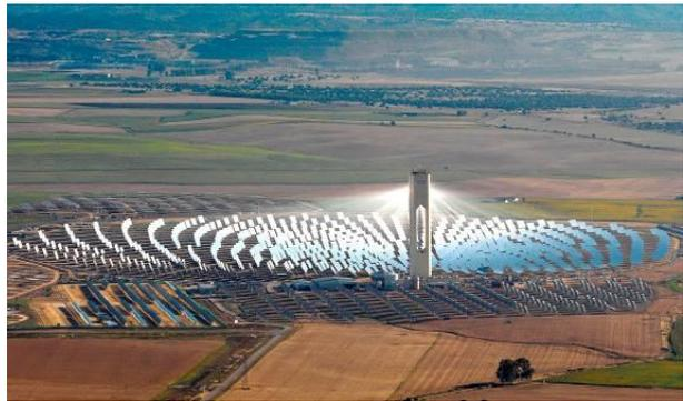
**Figura 4. Planta solar de receptor central. Fuente: Protermosolar.**
