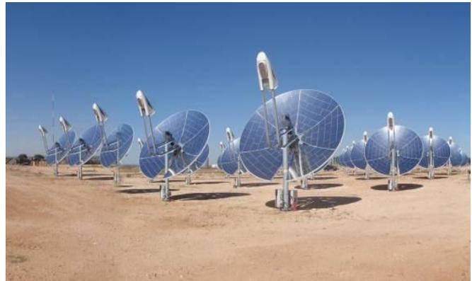
**Figura 6. Receptor de disco parabólico con motor Stirling. Fuente: Protermosolar.**
