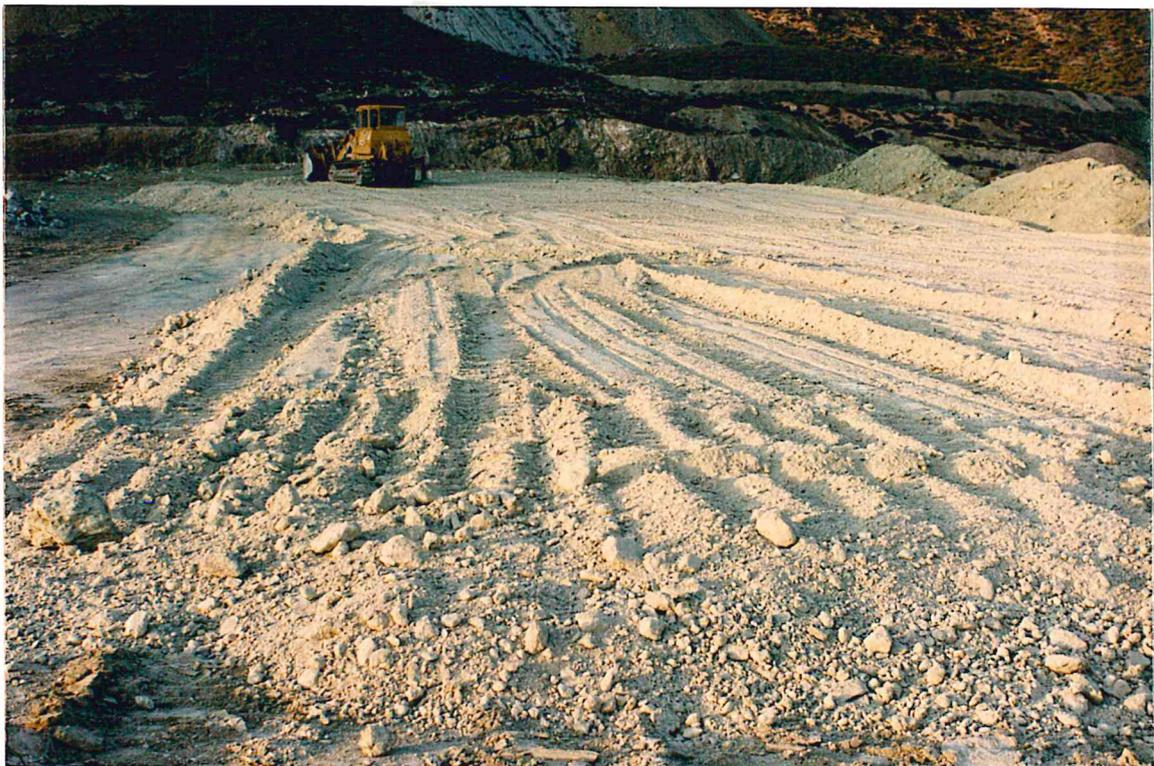
Fig. 10: La pala de cadenas extiende la bentonita dando forma a la parva
