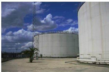
Ilustração 7: Digestores da planta de tratamento de vinhaças de Rum Brugal
