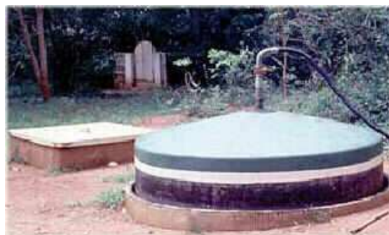
Ilustração 2: Digestor tambor flutuante
