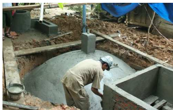
Ilustração 1: Digestor de cúpula fixa
