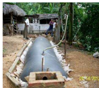
Ilustração 3: Digestor tubular
