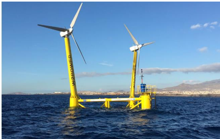
Figura 9. Prototipo W2POWER en el banco de ensayos de PLOCAN [24].
