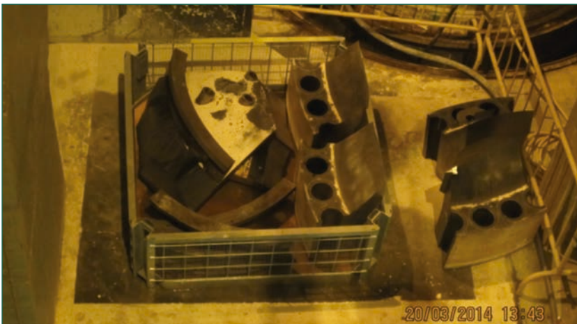
Figura 5. Cesta CE-2B con piezas de la tapa de la vasija del reactor.
