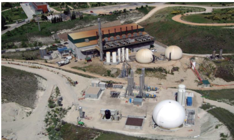
Figura 6.19. Foto de la Planta de Biometanización del biogás procedente de la gestión de la fracción orgánica y rechazo de los RSU de Madrid. Fuente: Cifuentes (2018).
