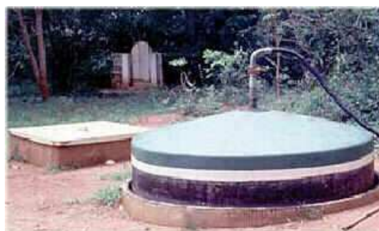
Ilustración 2: Digestor tambor flotante
