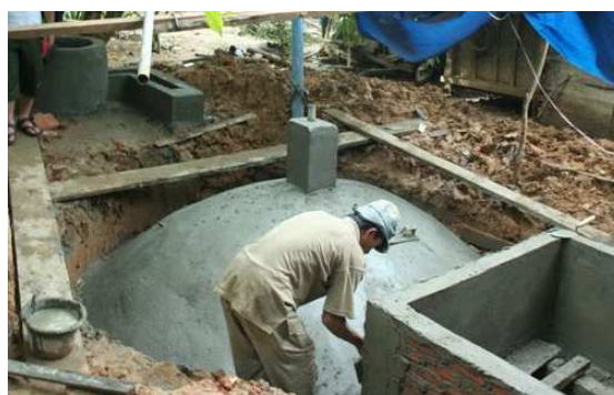
Ilustración 1: Digestor de campana fija
