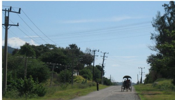
Figura 5.6: Fotografía que muestra la ubicación de la línea de media tensión con respecto a la carretera. Guamá, Cuba.
